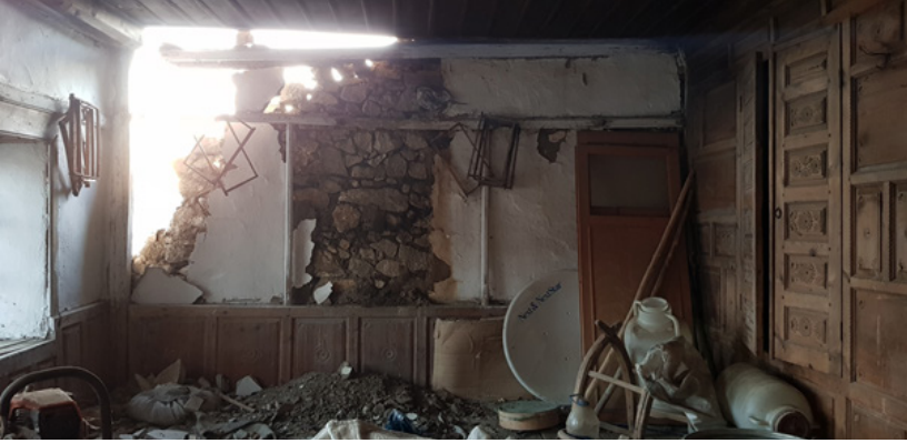
Foto 12: Oda iç mekânı batı cephesi
