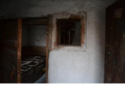
Foto 25: Aralık mekânı pencere ve kapı detayı
