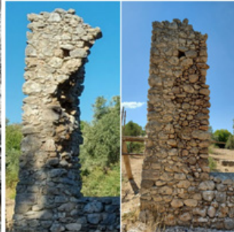
Fotoğraf 14: Kısmi onarım neticesinde konak duvarının öncesi ve sonrası hali
