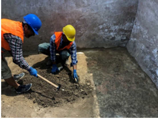
Fotoğraf 10: Sıva ile kaplı zemin
