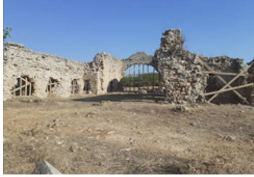
Fotoğraf 15: Kara paşa medresesi koruma ve güçlendirme çalışmaları
