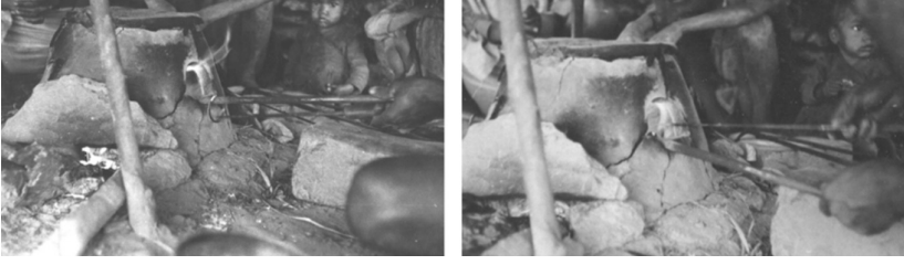
Resim 3a-3b: Dairesel planlı- konik kesitli- düz tavanlı fırında geleneksel cam bilezik üretimi- Nepal, 1970'ler. (Gaborieau 1977, s.117)
