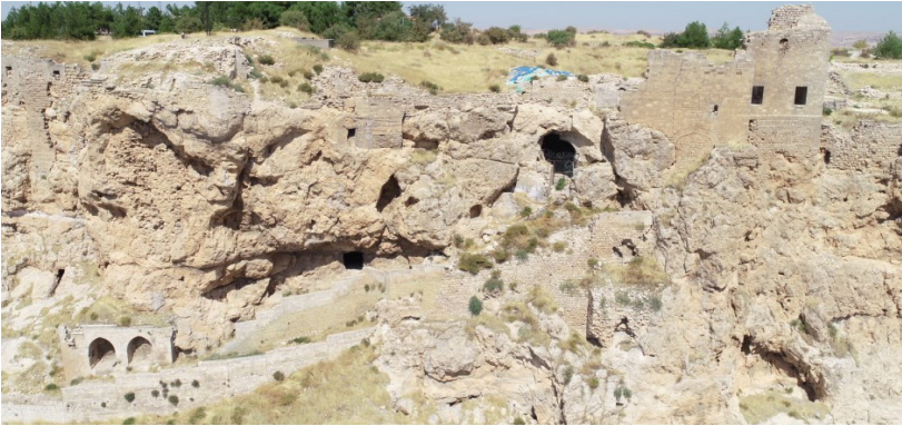
Mardin Kalesinin Güney Sur Duvarları Genel Görünüş
