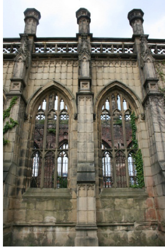
Görsel 8: St. Luke Kilisesi'nin Koro-Bema-Apsis Bölümü Pencere ve Payanda Sisteminden Detay.
