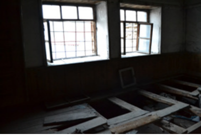
Foto 27: Oda iç mekânı güney cephe
