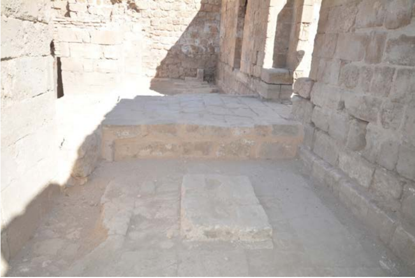
Tabanın Restorasyon Sonrası Görünümü
