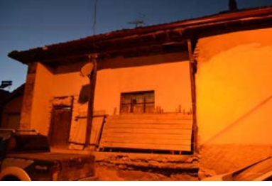
Foto 1: Köy odasının güney cephesi
