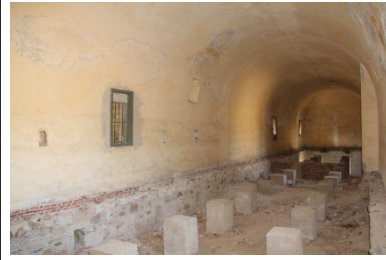
Fotoğraf 30: Batı bina iç mekân, güney taraf.
