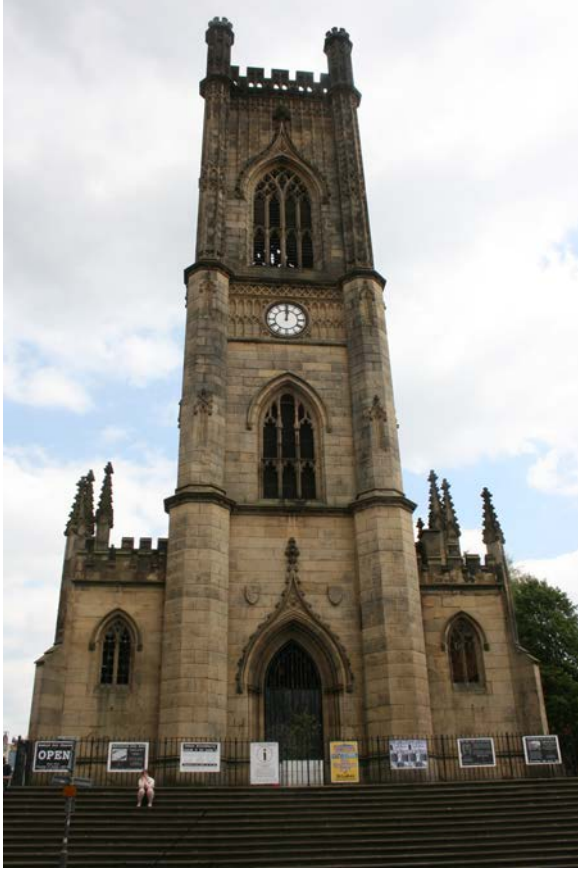
Görsel 3: St. Luke Kilisesi'nin Batı Cephesi.
