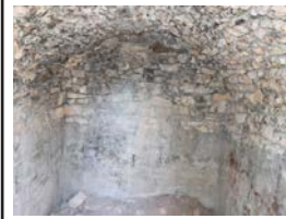
Fotoğraf-6: Sarnıçın içerisi ve tonoz üst örtü
