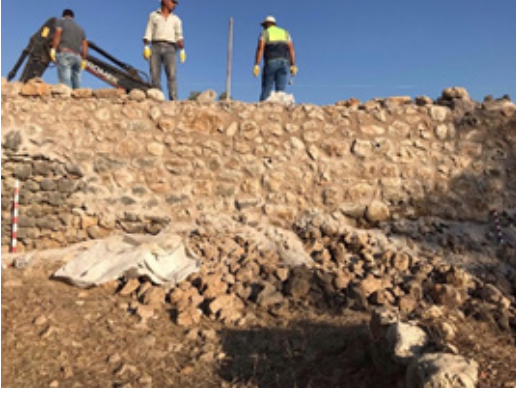
Fotoğraf 11: Sur duvarının onarımı
