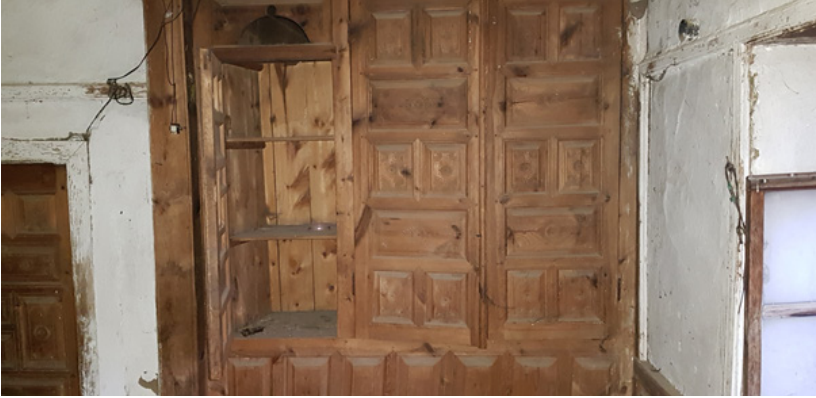
Foto 31: Oda iç mekânı doğusundaki yüklük ve yanındaki gömme dolap detayı
