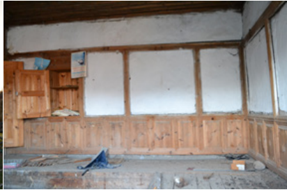
Foto 37: Oda iç mekânı kuzey cephesi
