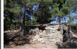
Fotoğraf-3: Güney-batı yönden görünüşü
