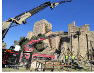
Fotoğraf 17: Kale girişindeki surların desteklenmesi
