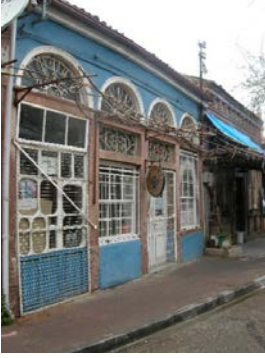
Res.7: Cephe ile aynı düzlemde dükkan kapısı
