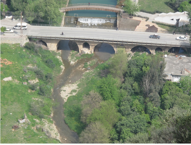
Resim11: Kozan Köprüsü Genel Görünüm (Eski Hali)
