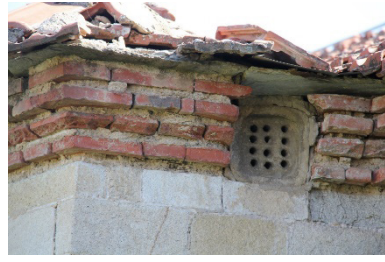
Fotoğraf 23: Güney bina havalandırma bacası.
