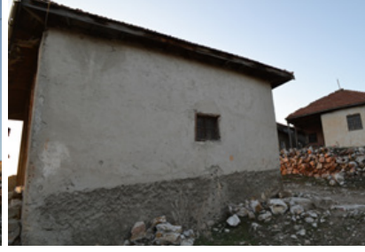
Foto 9: Köy odasının doğu cephesi
