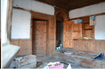
Foto 39: Oda iç mekânı batı cephesi
