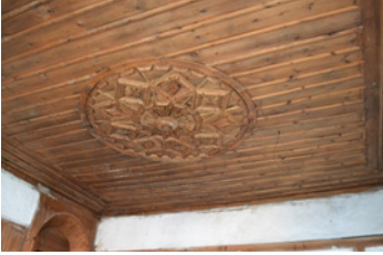
Foto 40: Oda iç mekânı tavan detayı
