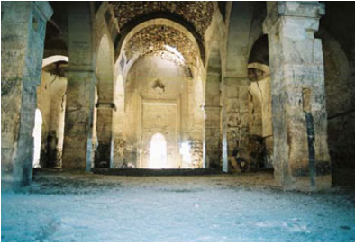
Şek 17. Divriği Kale Camiisi, onarımdan Şek 18. Divriği Kale Camiisi, iç mekân, sonra tonoz sivasız (bakırer) beşik
