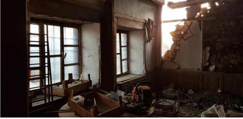
Foto 13: Oda iç mekânı güney cephe
