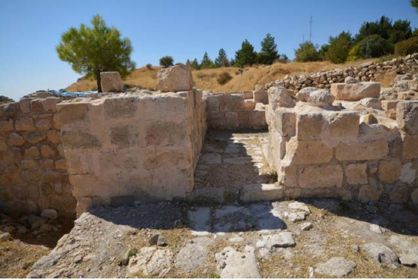
Duvarların Restorasyon Sonrası Görünüm
