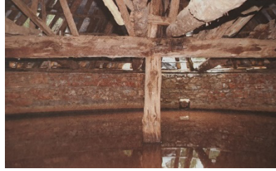
Fotoğraf-46: Sarnıçların üst örtüsünün desteklenmesi (Yıldız vd., s. 301)
