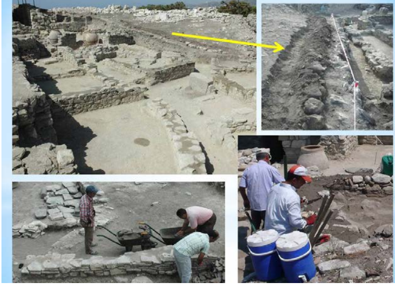
Res. 4. 2012 yılında anıtsal kilisenin kuzey ve batı yanında, kuru duvarlarda çamur harçla şapkalama ayrıntılarından: Üstteki iki karede çamur harçla kapatılan duvarların yanı sıra açmanın çevresinde hendek kazılarak yağmur akıntılarına karşı önlem alınmıştır.
