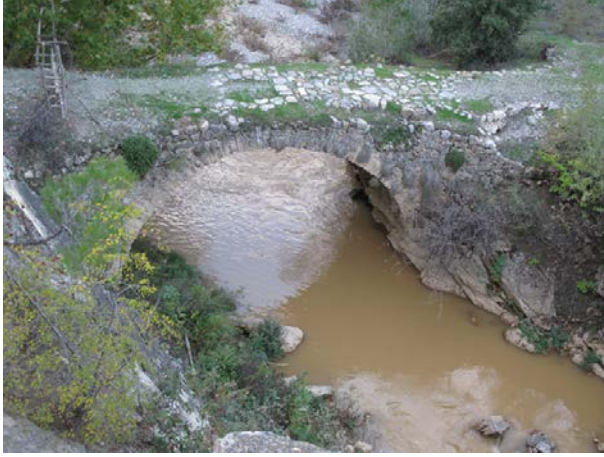
Resim 14: Himmetli Köyü, Eski Değirmen Yolu Köprüsü
