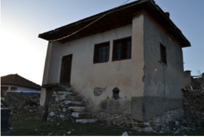
Foto 34: Köy Odası güney cephe
