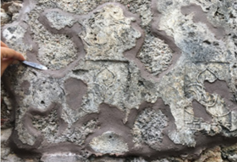
Fotoğraf 13: Sıva ve süsleme koruma uygulamalarından detay
