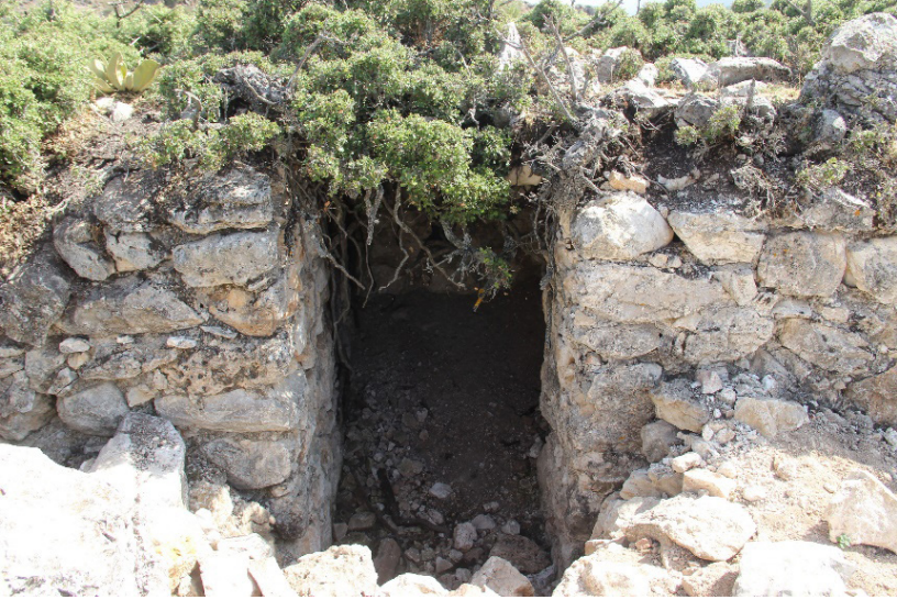
Foto.14: Islak mekâna geçişi sağlayan kapı açıklığı.
