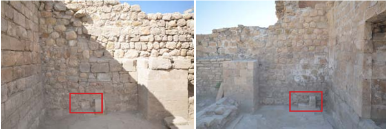
AF11 Ve AG11 Açmalarındaki 'Ters L' Formundaki Blok Taşlar
