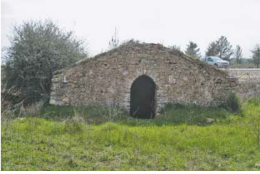
Fotoğraf-35: Antalya-Isparta Yolu üzeri dikdörtgen planlı tonozlu sarnıç (Duymaz, s. 233)
