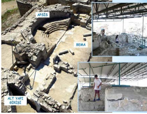
Res. 11 Kilisenin doğusundaki kazı ve temizlik çalışmalarının (2011) hemen ardından batı kesimdeki gibi apsis ve bema geçici örtülerle kapatılmıştır (2012). Sağdaki karelerde geçici örtünün metal giriş ve taşıyıcı ayakları görülmektedir.
