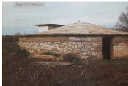
Fotoğraf-38: Hafif konik kubbeli, dairevi planlı sarnıç "Yeni Sarnıç" (Yıldız vd., s. 188)
