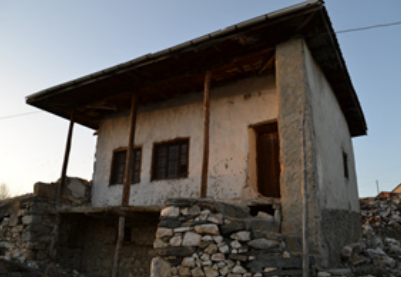
Foto 8: Köy odasının güney cephesi
