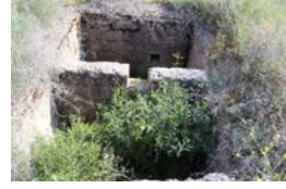
Fotoğraf-19: Çökertme havuzları
