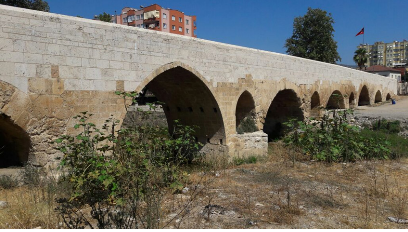
Resim 10: Kozan Köprüsü Güneyden Görünüm
