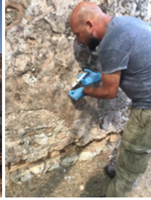
Fotoğraf 12: Bey hamamı sıva ve süslemelerinin korunması uygulaması
