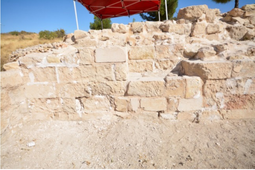
Duvarın Restorasyon Çalışması Sonrası Durumu
