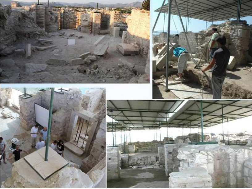
Res. 7. Nartekste sol üst köşede görüldüğü üzere kazılar devam ederken duvarlar kireç harçla şapkalanıp sağlam kesimlere geçici örtülerin metal bacakları için pabuçlar konulmaya başlanmıştır. Ayakların üzeri oluklu saçlarla kapatılmasıyla bu örtü altında çalışmalara devam edilmiş; ziyaretçiler ağırlanmıştır.
