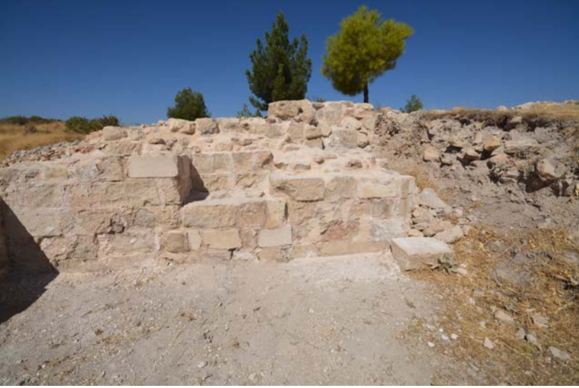
Duvarlarının Restorasyon Sonrası Durumu
