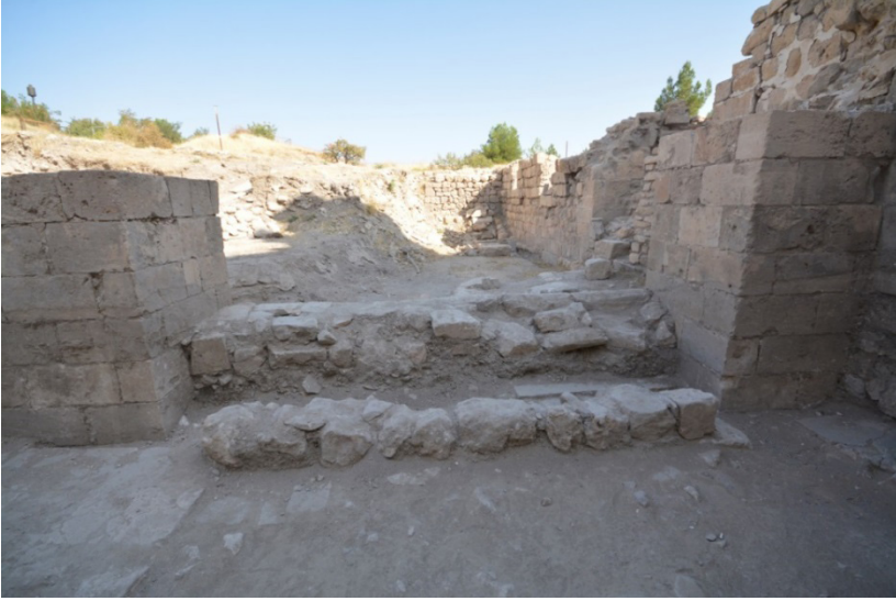
Ayaklar Arasında Yer Alan Duvarın Detaylı Görünümü
