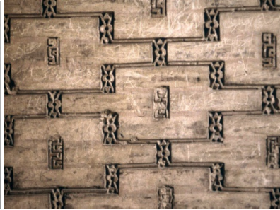
Şek 7. İsfahan, Mescid-i Cuma, güney doğu yan duvar (Bakırer)
