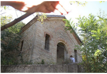
Fotoğraf 8: Güney bina girişi.
