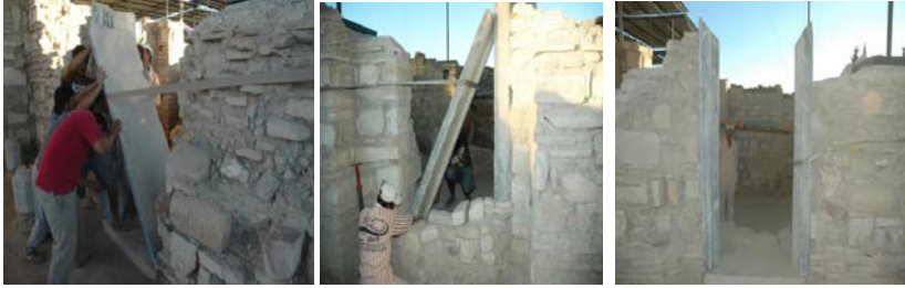
Res. 10 Teknik gereçlerin olmadığı ilk yıllardan günümüze kadar-ki hala donanımlarımızın yeterli olduğu söylenemez-her müdahale omuz gücüyle pratik olarak yapıldı: Kiliseden güney şapele geçişi sağlayan kapının söveleri, 1260 civarındaki depremden yüzyıllar sonra, 2012 yılında doğrultulmalarına ilişkin çalışmalar alttaki karelerde görülmektedir.
