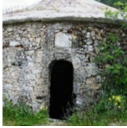
Fotoğraf-58: Muğla-Aydın Yolu Yerkesik Yolu üzerindeki sarnıç girişi (Öter, s. 147)
