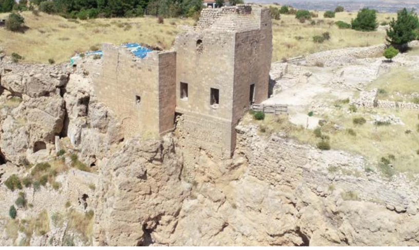
Kale Camii Güney Cephe Görünüşü
