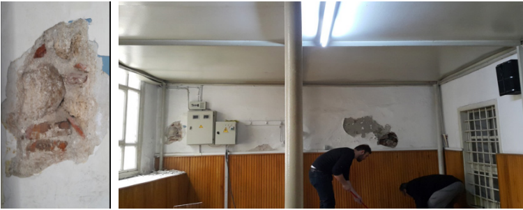
Fotoğraf 5: Güngörmez Mescidi son cemaat yeri doğu duvarı üzerinde yapılan araştırma raspasıyla ulaşılan duvar örgüsü
