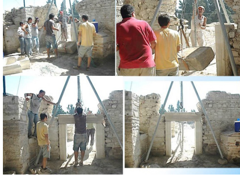
Res. 9 Kuzey yan meften nartekse geçişi sağlayan kapının, narteks içine düşmüş olan lentosunun caraskal yardımıyla yerine kaldırılması (2012)
