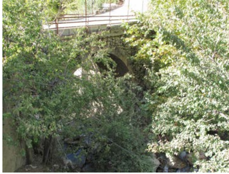
Resim 17: Saimbeyli, Hamurcu Köprüsü
