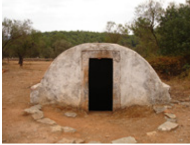
Fotoğraf-60: Muğla Bodrum Yalıköy Sarnıcı'nın giriş cephesinden görünümü (Öter, s. 175)
