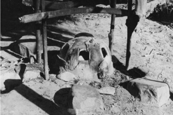
Resim 2: Dairesel plânlı- kubbemsi örtülü- dört çalışma pencerele cam bilezik fırını- Nepal- 1970'ler (Gaborieau 1977, s.112-117)
