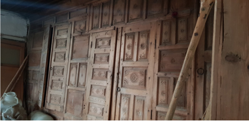
Foto 14: Oda iç mekânı kuzey cephede yer alan yüklük ve gömme dolaplar
