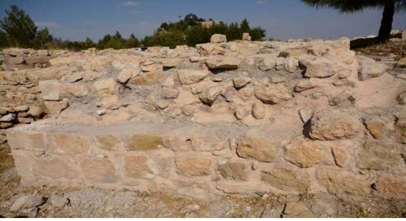
Duvarın Restorasyon Öncesi Hali
