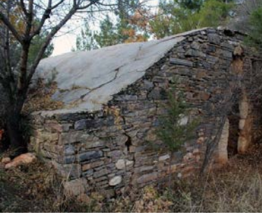
Fotoğraf-47: Uşak, Karahallı İlçesi, Beki Köyü, 1. sarnıç (Acar, s. 372)
