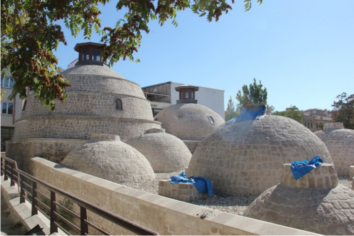
Resim 18. Hamamın restorasyon sonrası görünümü
