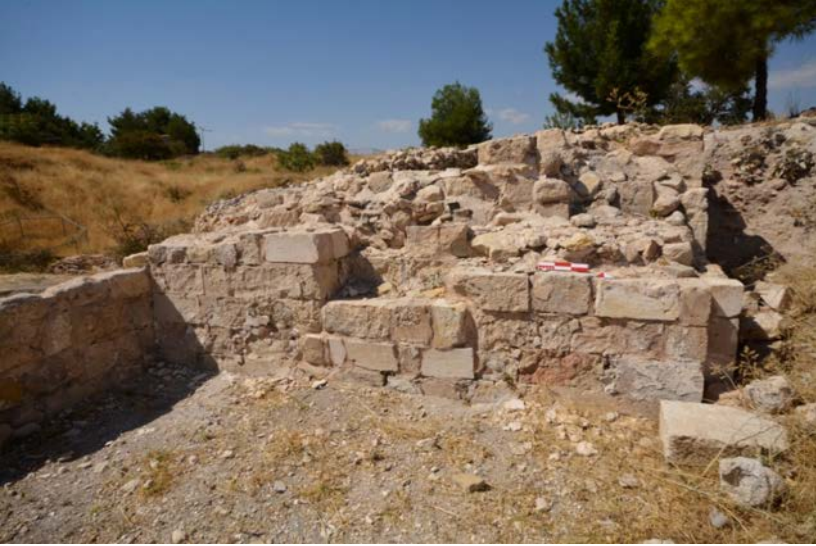
Duvarın Onarım Öncesi Görünümü
