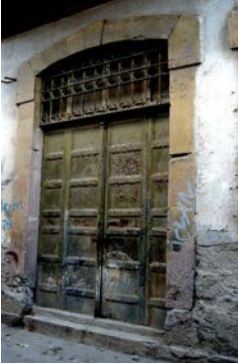
Res.4: Cephe ile aynı düzlemede fabrika kapısı
