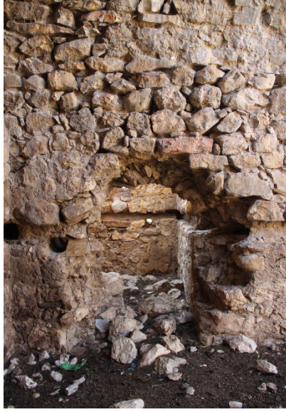
Foto.5: Kilise Adası, ıslak mekâna geçiş sağlayan kapı açıklığı.
