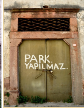
Res.6: Cephe ile aynı düzlemede depo kapısı
