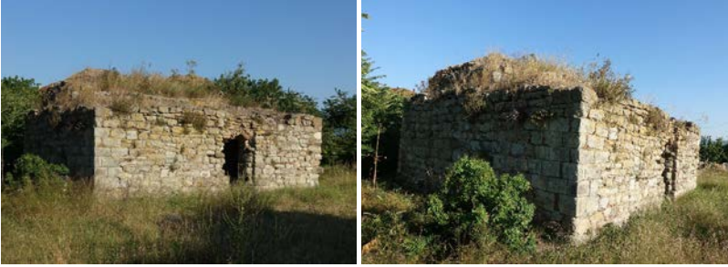
Resim 78-79. Hersekzade Hamamının ön ve yan cepheye ait fotoğraflar
