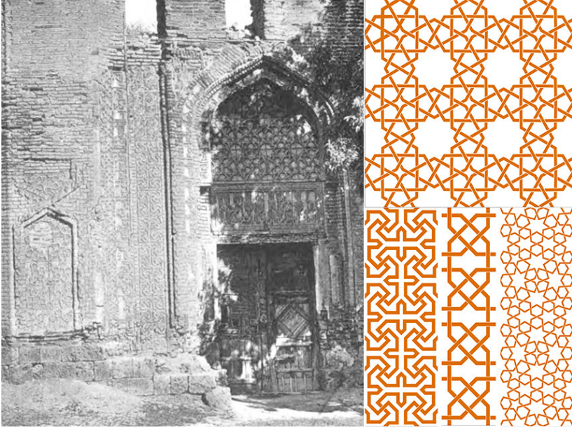
Görsel 11. Van Ulu Camisi A-20. Yüzyılın Başlarında Taçkapının Durumu (W. Bachmann'dan) B-Giriş Alınlığındaki Panonun Model Çizimi C-Dıştan 3. Bordürün Model Çizimi D-Dıştan 2. Bordürün Model Çizimi E-Dıştan 1. Bordürün Model Çizimi
