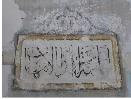
Fotoğraf 21: Harim Batı beden duvarı üzerinde raspa ile açığa çıkarılan Hadis
